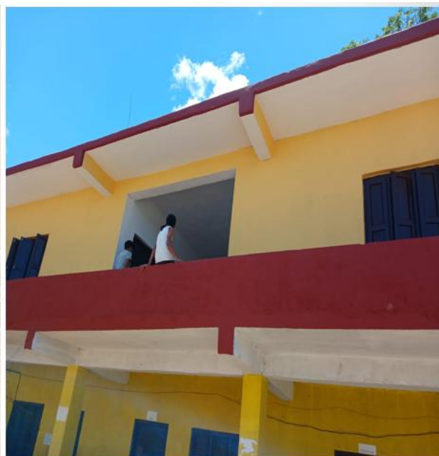
महेन्द्र मा वि विद्यालय भवन निर्माण
