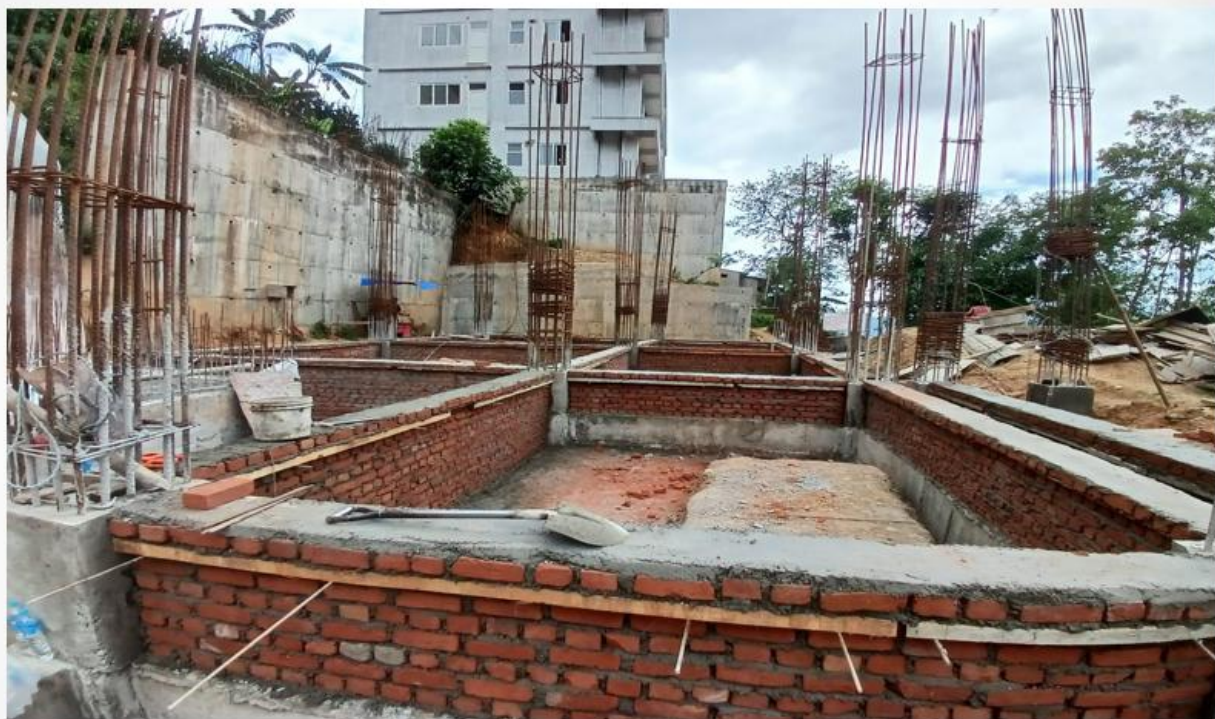
निर्माणाधिन प्रशासकीय भवन
