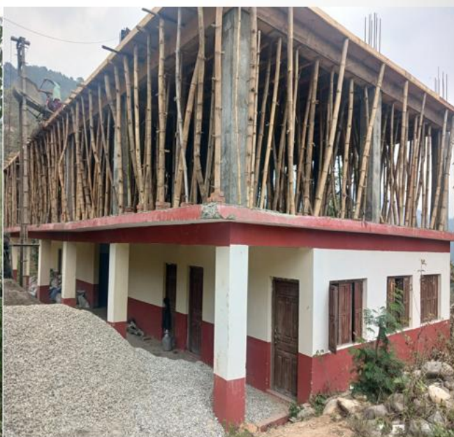
सरस्वती आ.वि भवन निर्माण
